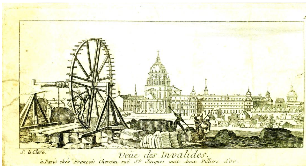
Vue du chantier des Invalides
