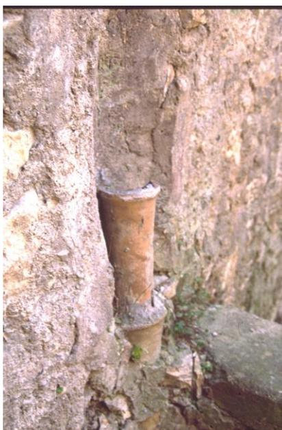
Viviers, cour de la maison « De Pretiosa ». Système d'amenée d'eau. A gauche, négatif des bourneaux dans le mur. A droite, bourneaux encore conservés à proximité de la citerne.
